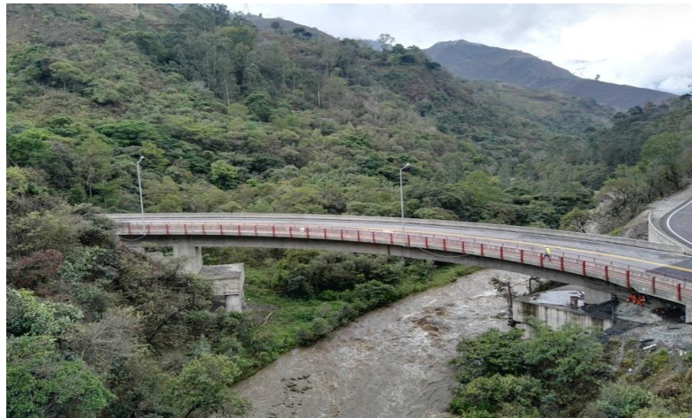
Obra: Puente Río Sáname
