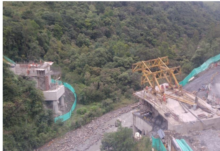
Construcción Puente Saname; Vía Bogotá- Villavicencio
