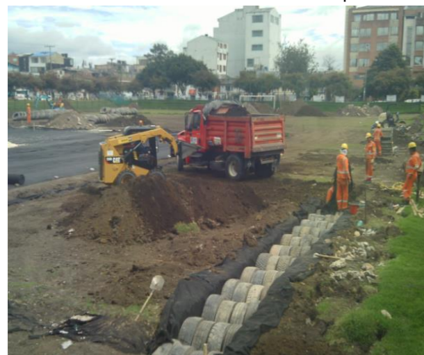
Instalación de llantas Rin 22,5 de Tracto Camión - Parque Tabora
