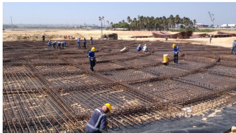
Construcción losa de cimentación obra: Palermo Tanks.
